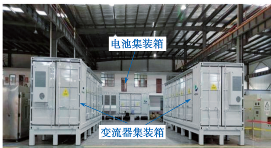
图9 装有一体化变流器和电池的集装箱
